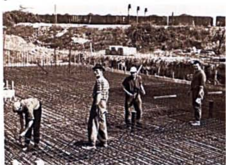
Baubeginn im April 1967
