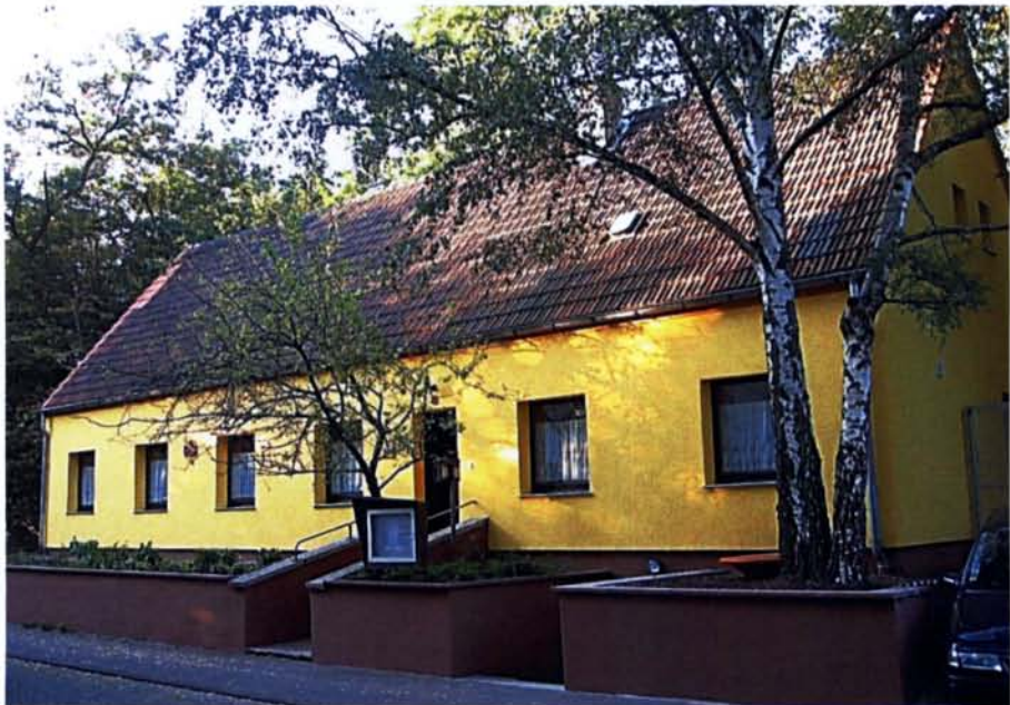
Heim Mitte im Zustand der Renovierung um 2005
